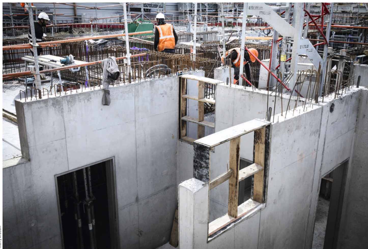
Les ouvriers ont posé les fondations du bâtiment H (74 logements sociaux) situé le long de la rue Victor-Hugo.
