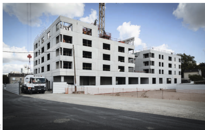
Au nord, l'immeuble du lot E3 (46 logements sociaux) situé devant le futur groupe scolaire.
