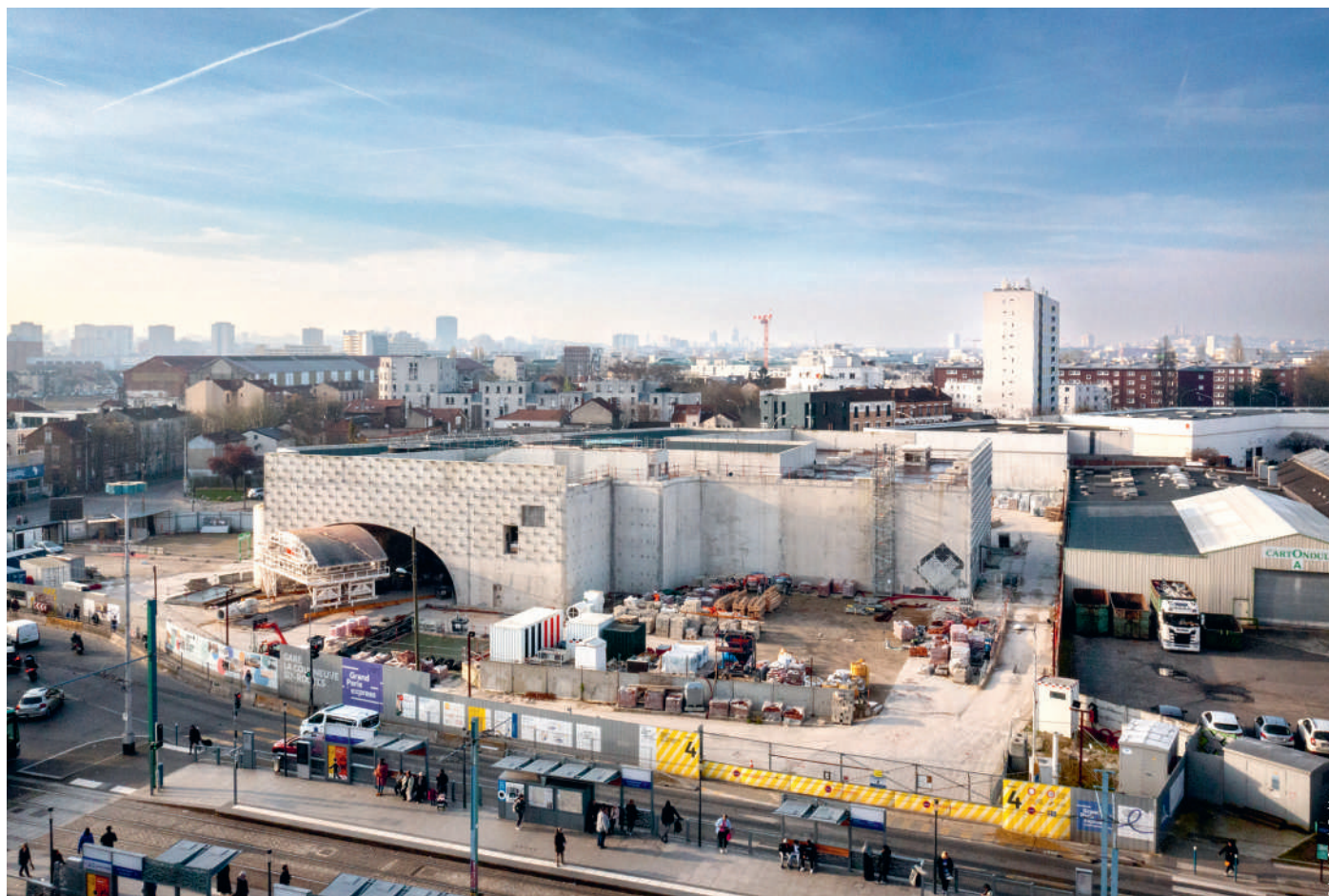
Les escaliers mécaniques et les ascenseurs qui permettront de parcourir les différents niveaux de la gare du Grand Paris Express seront installés cette année.
