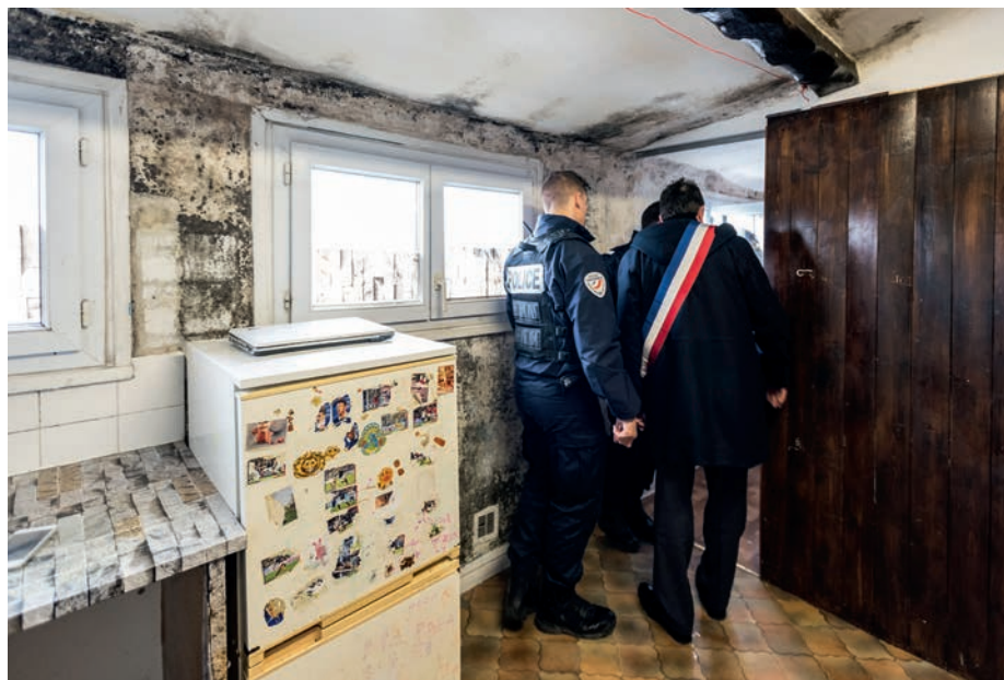
En janvier 2018, le maire a fait murer un logement insalubre.
