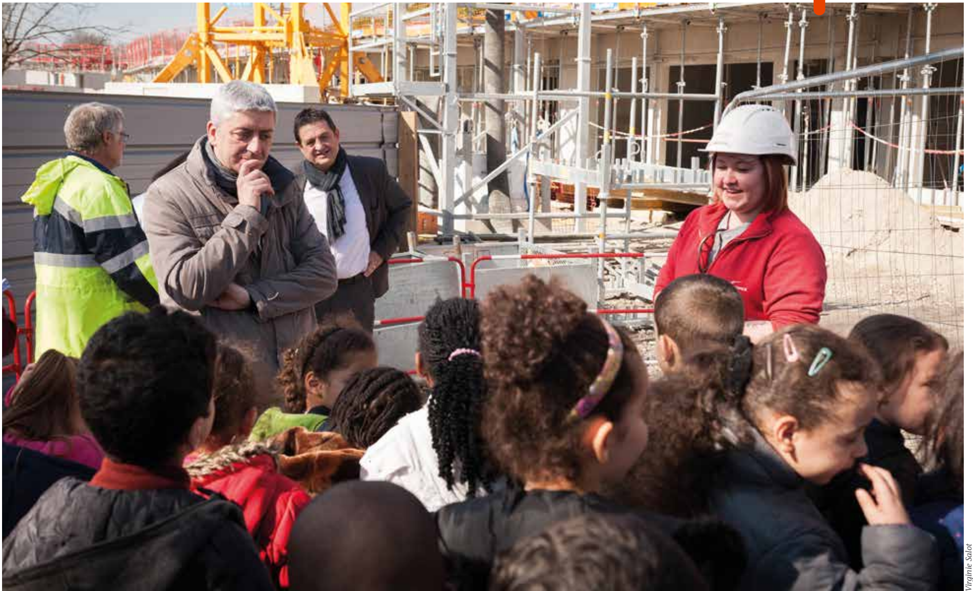
Élise, l'assistante du chef de chantier (avec le casque), explique aux enfants de l'école Rosenberg les étapes du chantier de leur futur groupe scolaire.
