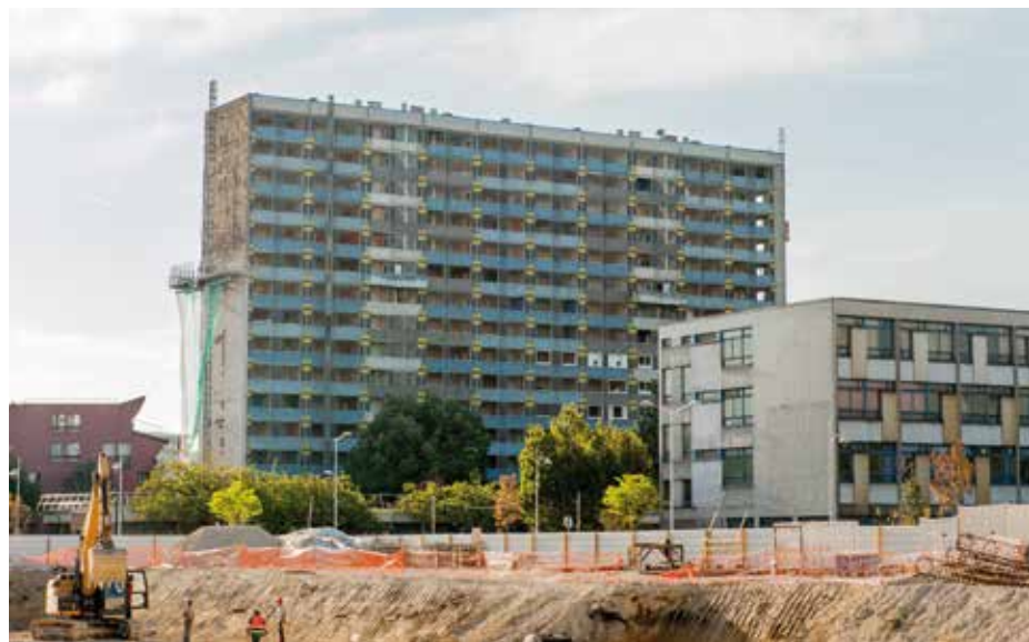
Le chantier du Petit Debussy est provisoirement suspendu.
