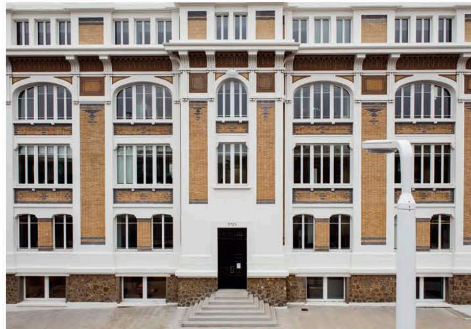
Le bâtiment du centre fiduciaire de la Banque de France implanté à La Courneuve, rue des Usines-Babcock.
