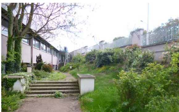
Vue sur le talus à l'intérieur du site d'étude.
