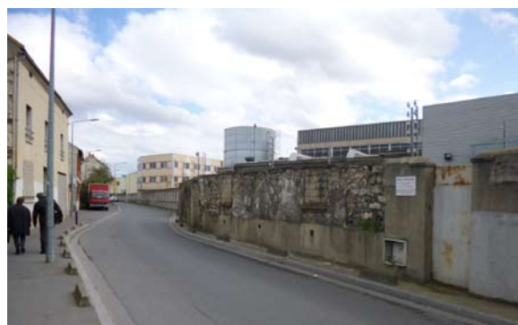
Vue sur le mur de clôture et les bâtiments industriels du site.
