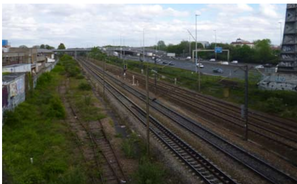
Vue sur la voie ferrée.
