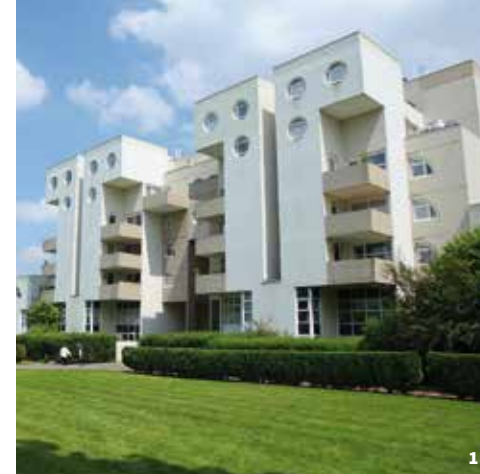
1. Logements de l'allée des Bois, Claude Vasconi © Yann Piriou, 2008
